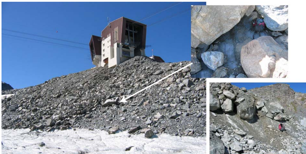
Fig. 4.4. Les bâtiments sont ancrés dans une moraine gelée. A l'aval, de la glace morte affleure sous les sédiments.
