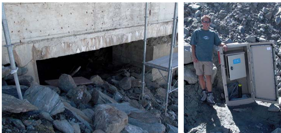
Fig. 4.12. A gauche: vue sur les fondations de la gare de départ du téléphérique du Mont Fort. La distance entre la surface du terrain et la dalle de béton est d'environ 2 mètres. A droite: une année après la réalisation du forage, l'armoire qui contient le MADD avait subi un basculement latéral conséquent. Photo: E. Reynard.
