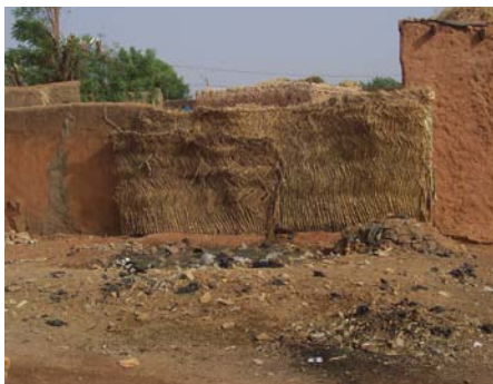
ASSAINISSEMENT INDIVIDUEL DANS LA RUE (HABITAT DE TYPE COUR EN BANCO)
