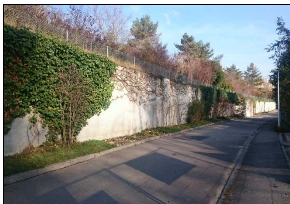
Figure 14 : Amélioration de la banquette en pied de mur et végétalisation du mur
