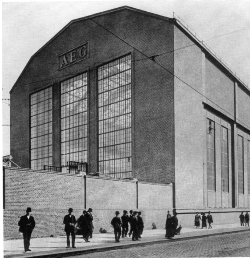
Fig. 4. Peter Behrens, Turbinenfabrik-AEG, Berlin, 1909.
