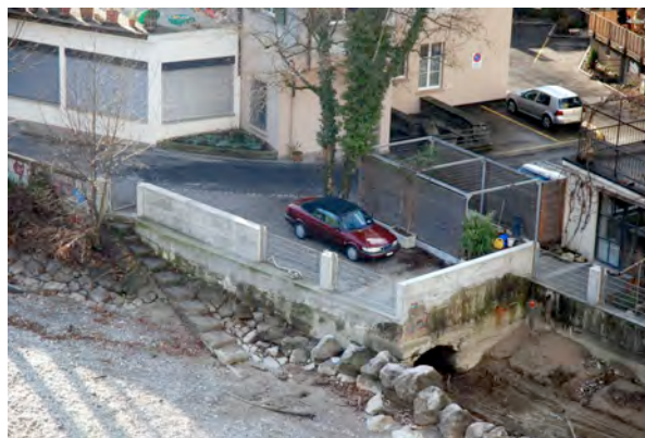
Abb. 7.15. Schutzmauer (mit Dambalkensystem) in der Wasserwerksgasse (Foto: L. Thomi).
