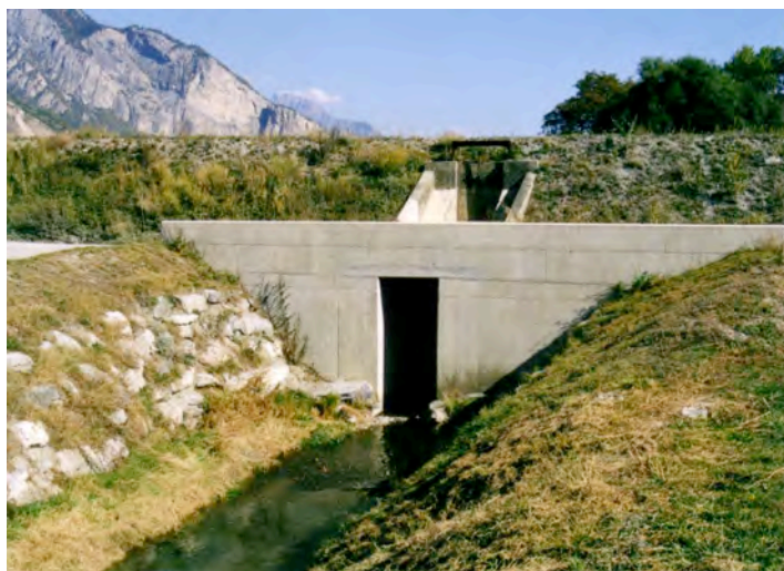
Fig. 9.10. Le ponceau du canal LSF sous le torrent de la Salentse (photo : L. Thomi).
