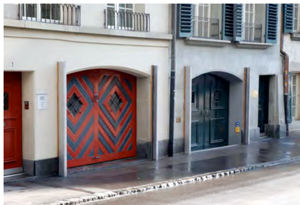
Abb. 7.16. Dambalkensystem an einer Liegenschaft in der Gerbergasse (Foto: L. Thomi).
