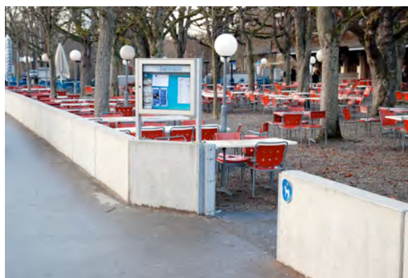
Abb. 7.11. Objektschutz beim Restaurant Dählhölzli (Foto: L. Thomi).
