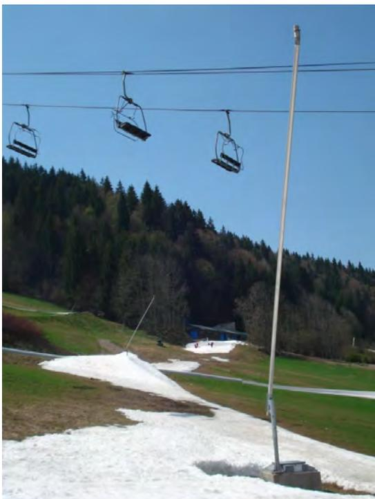
Ils sont appelés ainsi car ils utilisent deux flux, un flux d'eau sous pression et un flux d'air comprimé. Ils sont toujours fixes et montés sur de grandes perches disposées en bordure de piste. Ce sont les enneigeurs les plus couramment utilisés en France. Ils peuvent être implantés au-dessus du niveau du sol (3 m) ou en hauteur (perche de 6 à 12 m). Ils sont généralement associés pour leur fonctionnement à un système de pilotage à distance.
