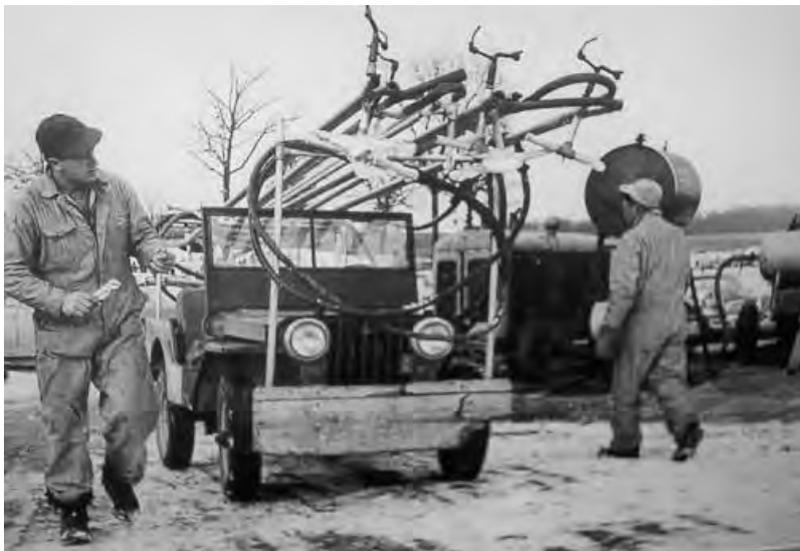
**Figure. 42 Le système d'enneigeurs installé sur une jeep pour étendre les surfaces enneigeables, station de Wilmot dans le Midwest, 1952.** (<http://home.earthlink.net>).
