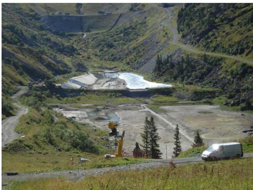
**Figure. 92 Aménagement du lac 1730 avec la pose de bâches étanches sur le second bassin.** (Cliché : Juillet 2010, E. Magnier).
