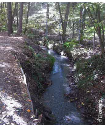
Bisse Neuf, à Miège, un canal creusé directement dans le versant
