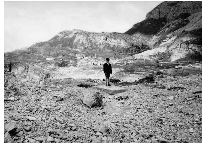
Figura 5. Un bambino fotografato sulla frana del Vajont, sullo sfondo la frazione di Casso soprastante la diga di quasi 250 metri e lambita dall'onda d'acqua sollevata dalla caduta della frana nel bacino idroelettrico, 25 aprile 1964 (ASAq-ASBI, APV, busta 20, fascicolo 1; concessione 1/2015, prot. 398, 10.2.2015).
