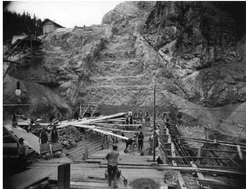
Abbildung 4. Baustelle der Staumauer Erlaufklause, Mai 1911 (Gemeinde Mitterbach a. E., Sammlung Wenzelburger, Nr. 550).
