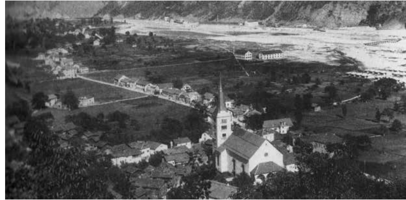
Abbildung 2a. Um 1900 zog sich ein bedeutender Teil des neuen Italienerquartiers von Naters entlang der alten Furkastrasse gegenüber der Tunnelbaustelle auf der anderen Uferseite der Rhone (Stiftung historisches Erbe der SBB Bern).
