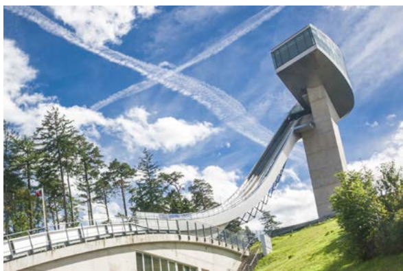
Le tremplin de saut à ski du Bergisel utilisé pour les Jeux d'hiver de 1964 et 1976, ainsi que pour les Jeux d'hiver de la jeunesse 2012. La tour de départ a été complètement rénovée par l'architecte star Zaha Hadid en 2002 et devient un monument emblématique de la ville
