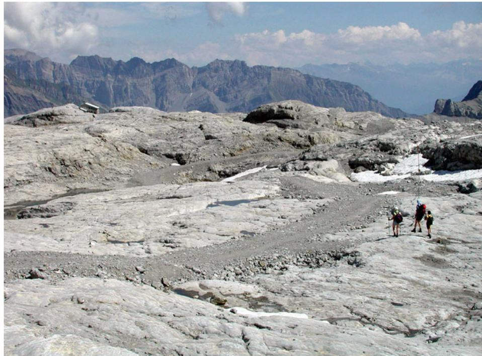
*Fig. 8 Route aménagée sans autorisation de construire sur le karst de Tsanfleuron. Les matériaux utilisés proviennent du démantèlement de la moraine de 1850. A l'arrière-plan, on devine la cabane de Prarochet.*
