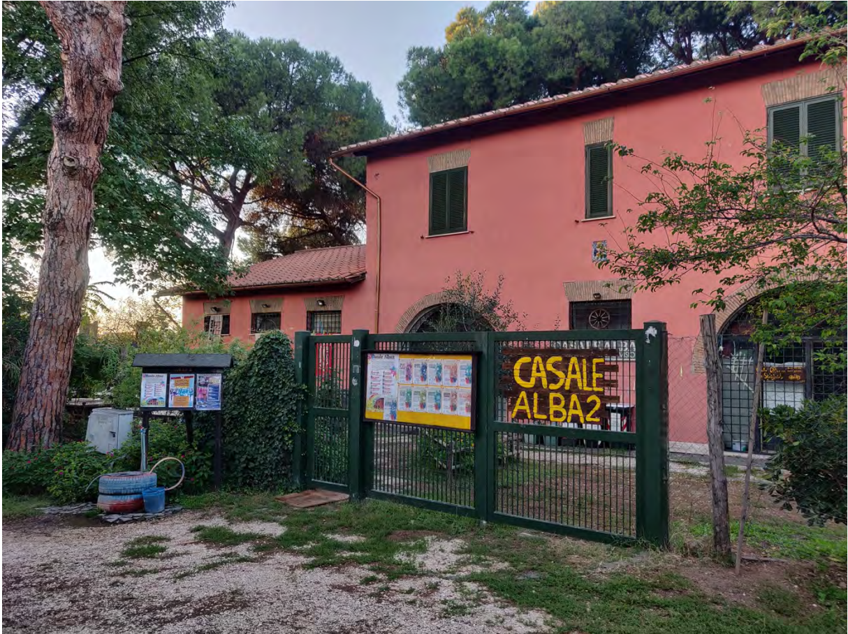
Figure 69 — En passant devant cet immeuble situé en plein milieu d'un parc, on se rend compte que quelque chose s'y passe. Pourtant, les signes extérieurs restent discrets (photo : Simone Ranocchiari, 3 octobre 2018).
