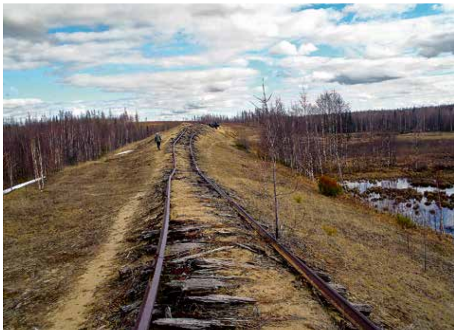
Fig. 3. Remblais de la voie ferrée 501.
