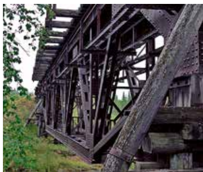
Fig. 2. Pont sur la rivière Penzer-lakha (vue est).
