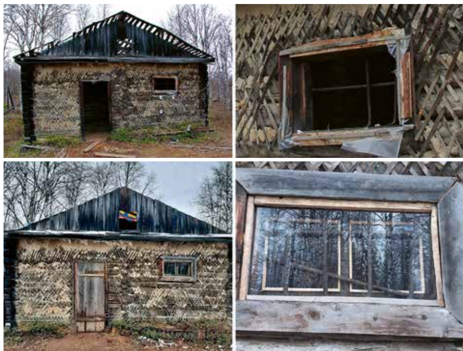
Fig. 6. Isolateur disciplinaire en 2019 (haut) et après sa rénovation en 2020 (bas).
