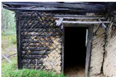
Fig. 5. Entrée du sas d'un baraquement.
