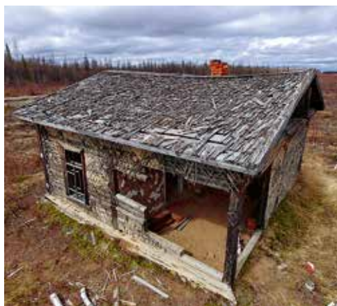
Fig. 6. Bâtiment d'exploitation de la voie ferrée, avec son toit de bardeaux.
