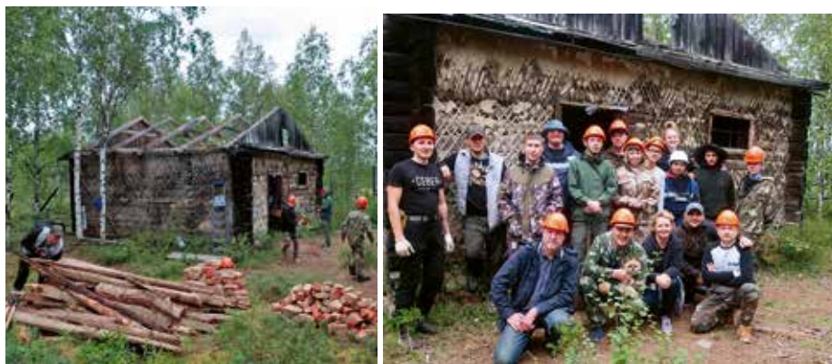
Fig. 5. Travaux de restauration sur le camp 93 (été 2020).
