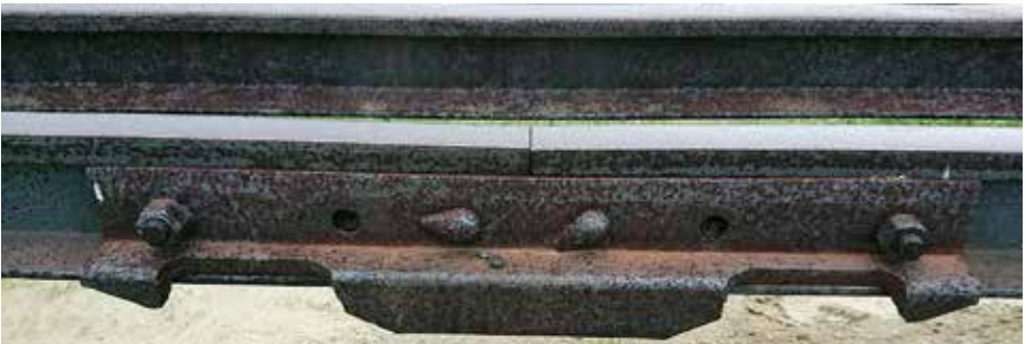
Fig. 7. Rails avec éclisse.
