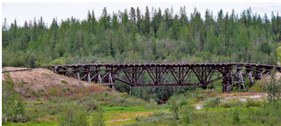
Fig. 1. Pont sur la rivière Penzer-lakha (vue sud).
