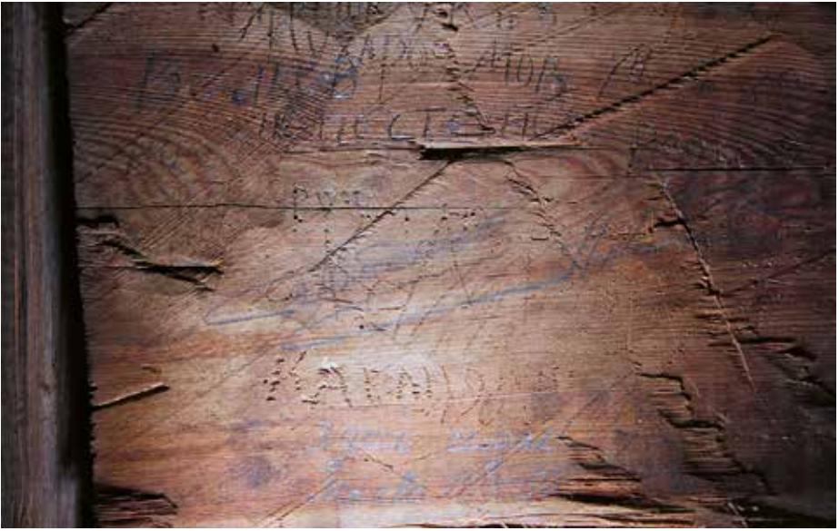
Fig. 3. Paroi de la cellule nord-ouest : inscriptions multiples sur un madrier.
