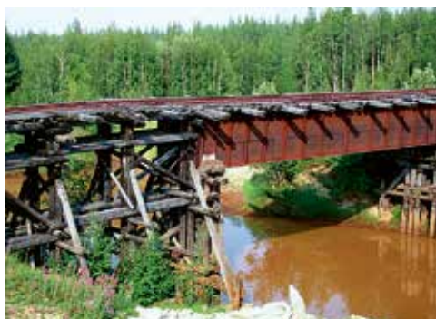
Fig. 3. Pont sur la rivière Id-lakha (vue sud-ouest).
