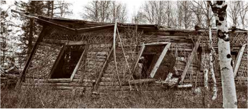
Fig. 4. Vue extérieure du bâtiment administratif est (B8).
