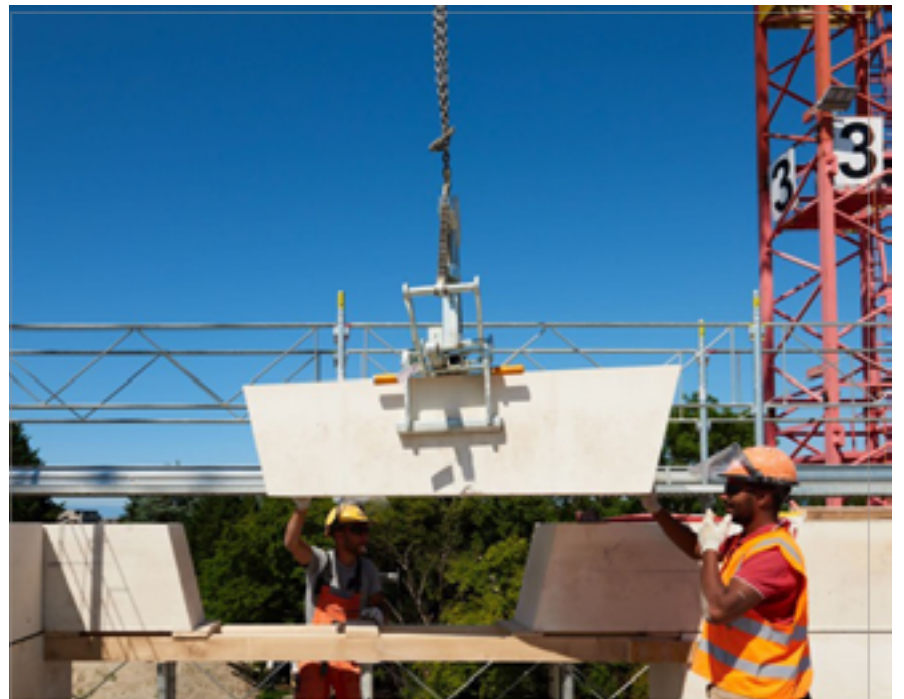
Chantier construction en pierre
