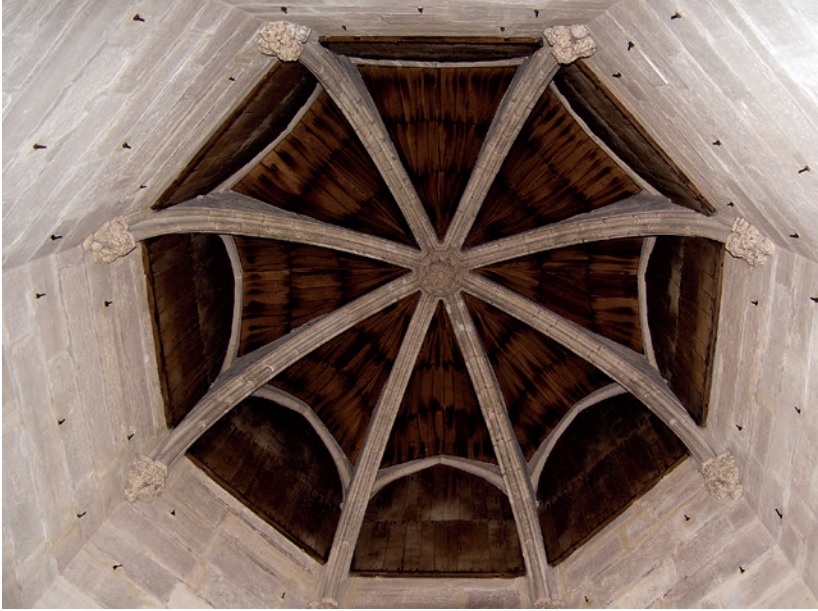
Fig. 1 — Vincennes, tour maîtresse, second étage, tourelle sud-ouest : voûte lambrissée. Photographie A. Salamagne.
