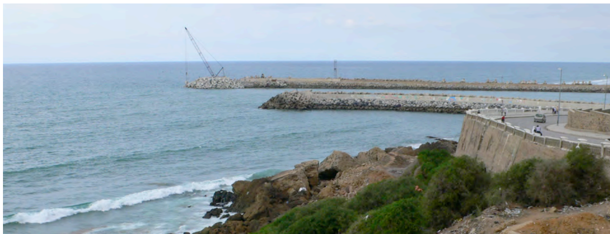
Fig. 65 : La digue du port de Larache (A. Pichot 2008)
