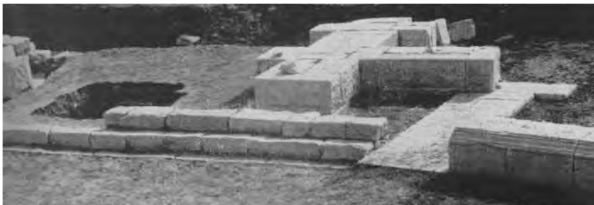
Fig. 63 : Les fondations de l'arc monumental du cirque de Sitifis (Février 1966, p. 31)
