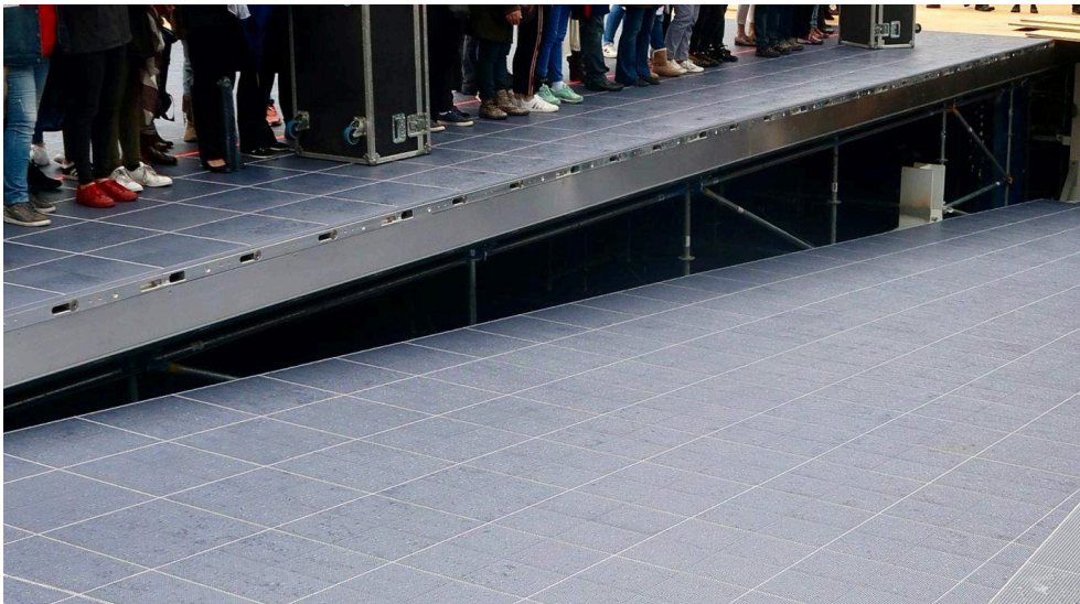
Photo 3 : rampe qui s'ouvre dans le tapis de LED
