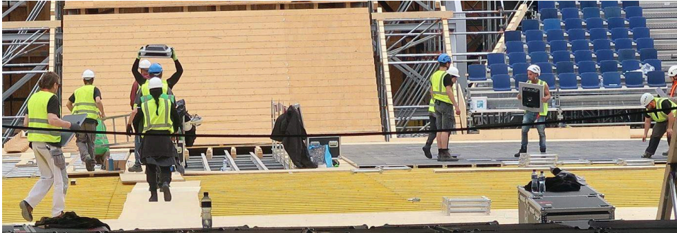
Photo 6 : pose du tapis de LED
