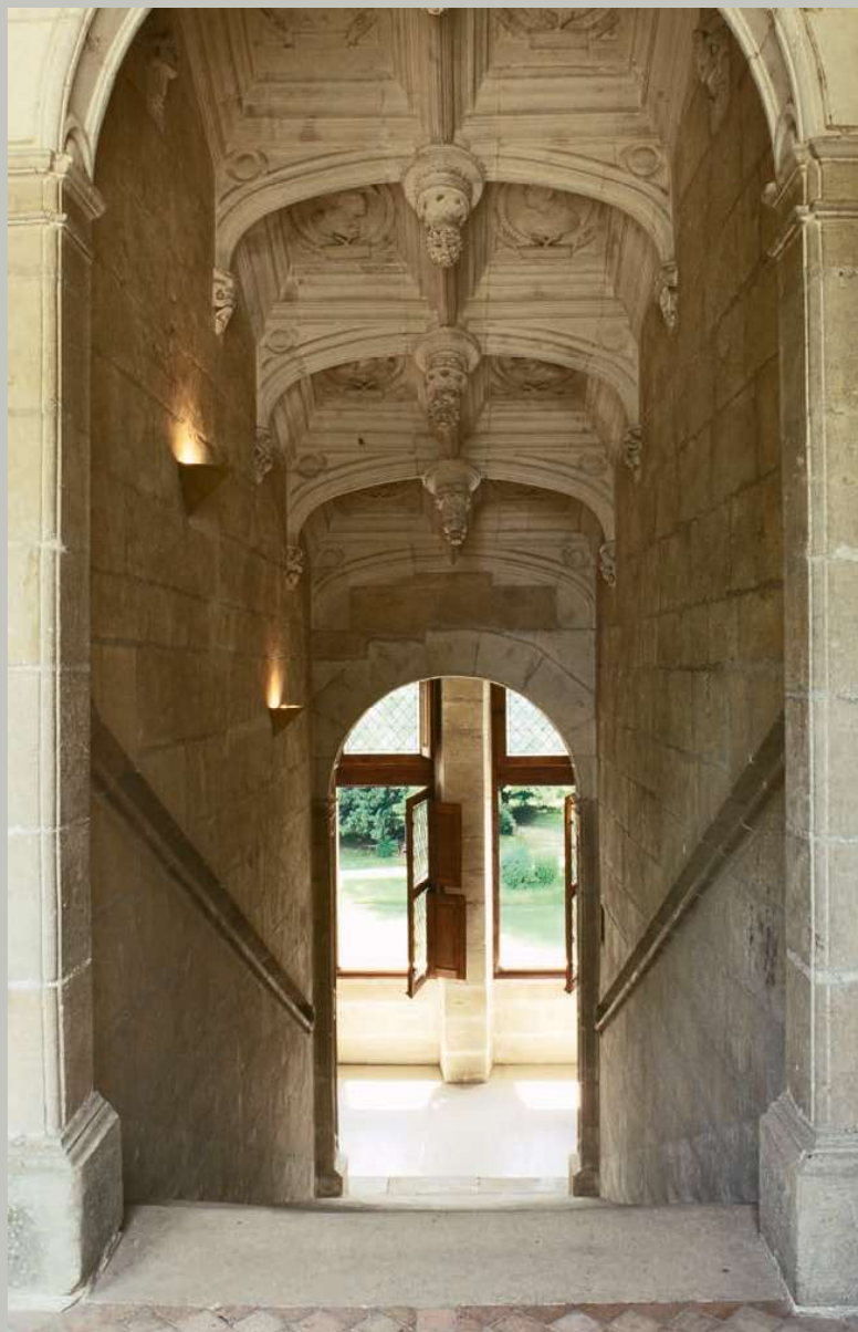
61 Vue générale de la troisième volée de l'escalier d'Azay-le-Rideau.
