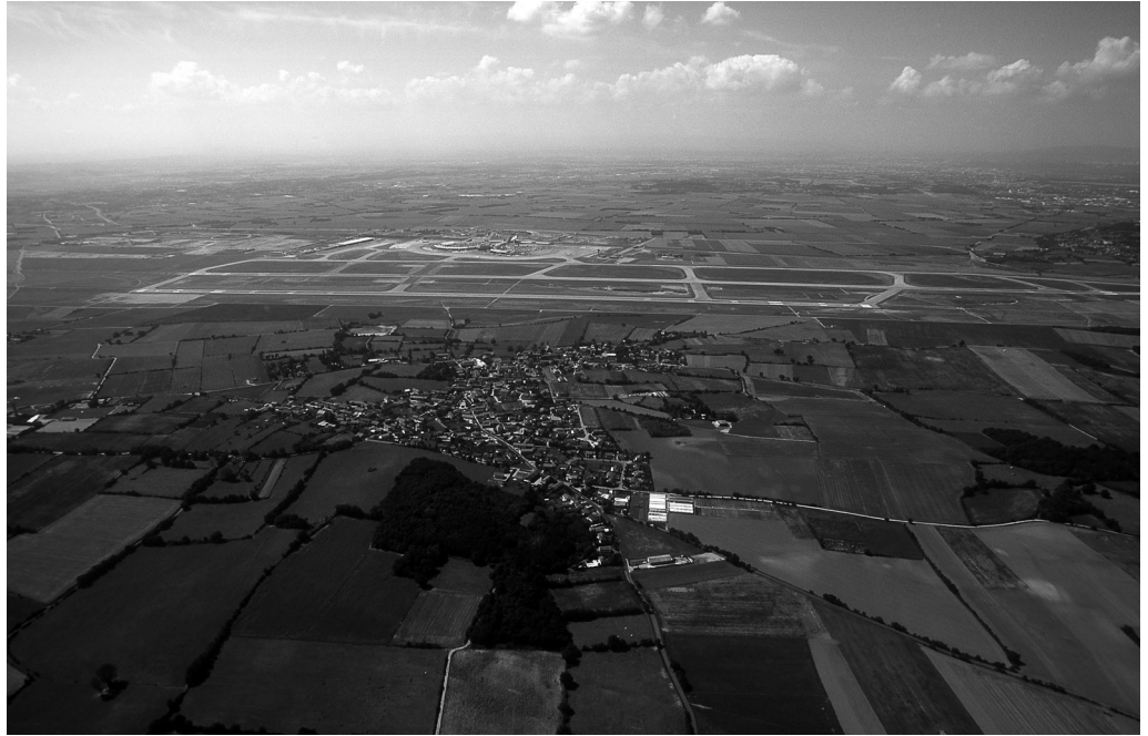
Figure 6 : La plateforme Lyon-Saint Exupéry dans la plaine de l'Est lyonnais (arrière plan : agglomération lyonnaise, premier plan : commune de Colombier-Saugnieu). Crédit photo : Agence d'urbanisme de Lyon
