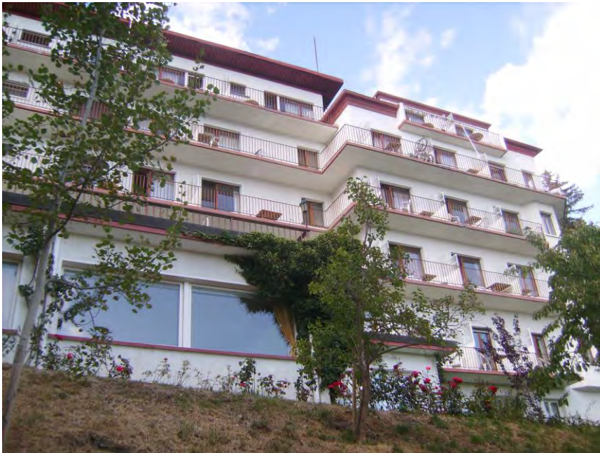
24. Markus Burgener Hôtel Eden, 1928, démolition 2012, photographie S. Doriot, 2011.
