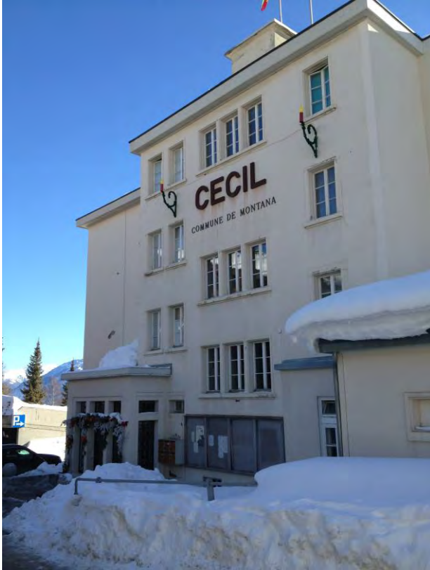
23. Ancien sanatorium du Cécil, 1929, et bâtiment communal, démolition juillet 2014, photographie S. Doriot, février 2012.
