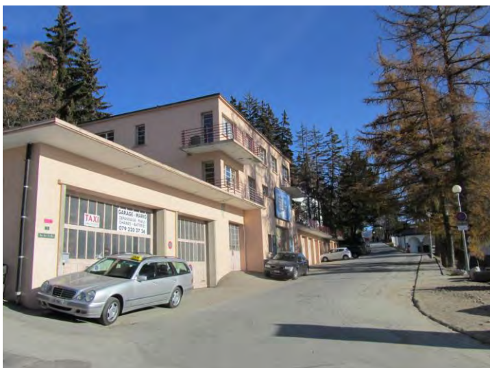
12. Garage Moderne SMC, 1929, démolition 2012, photographie S. Doriot, novembre 2012.
