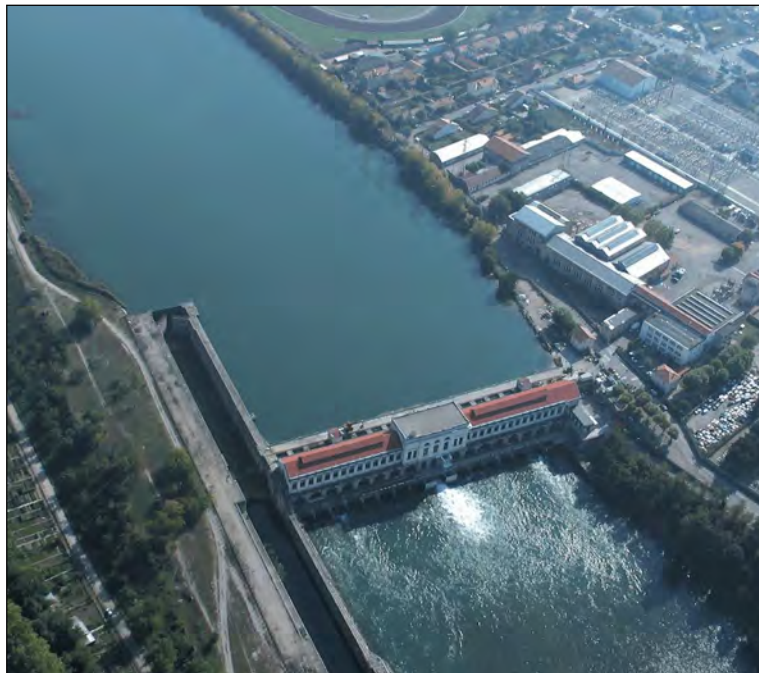
Figure 16 : L'usine hydroélectrique de Cusset (Grand Lyon, 2007)
