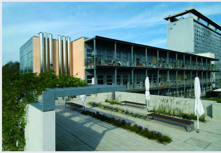
Der Neubau des Interdisziplinären Zentrums für Palliativmedizin des Klinikums der Universität München wurde mit Unterstützung der Deutschen Krebshilfe und des Freistaates Bayern errichtet
