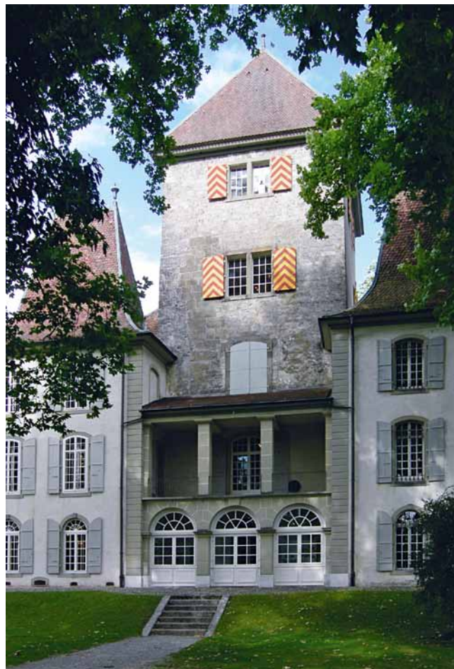
Fig. 8 Jegenstorf, château, façade latérale ouest.
