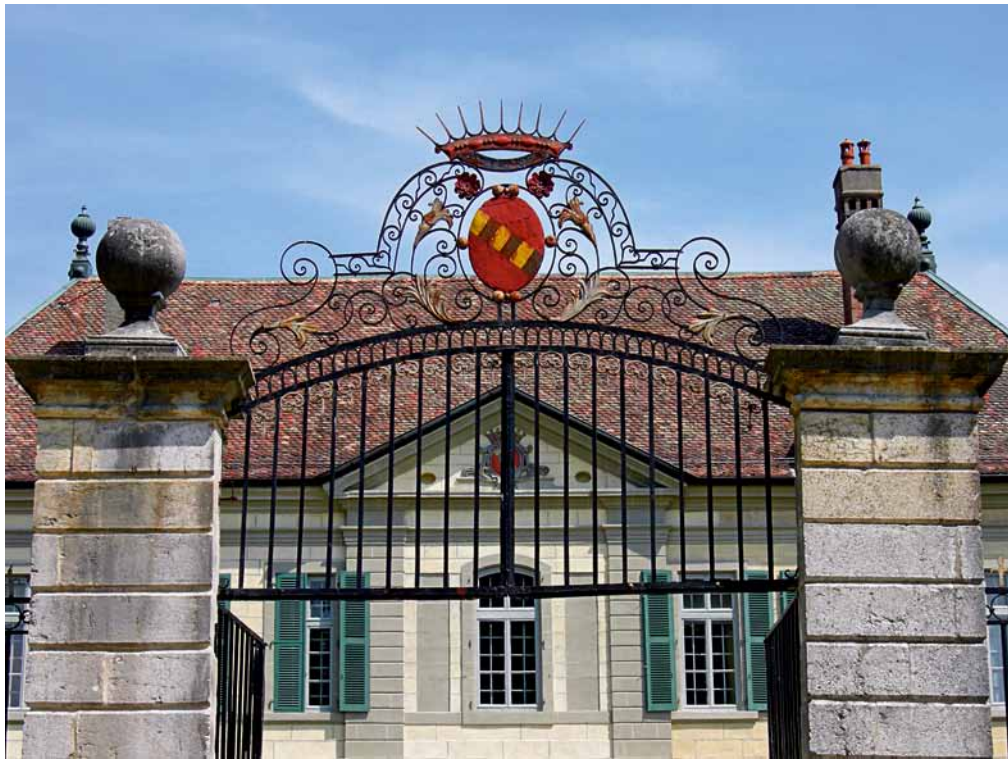
Fig.9 Vullierens, le portail de la cour, réalisé en 1715 par le serrurier Gontard selon un dessin de Guillaume Delagrance.
